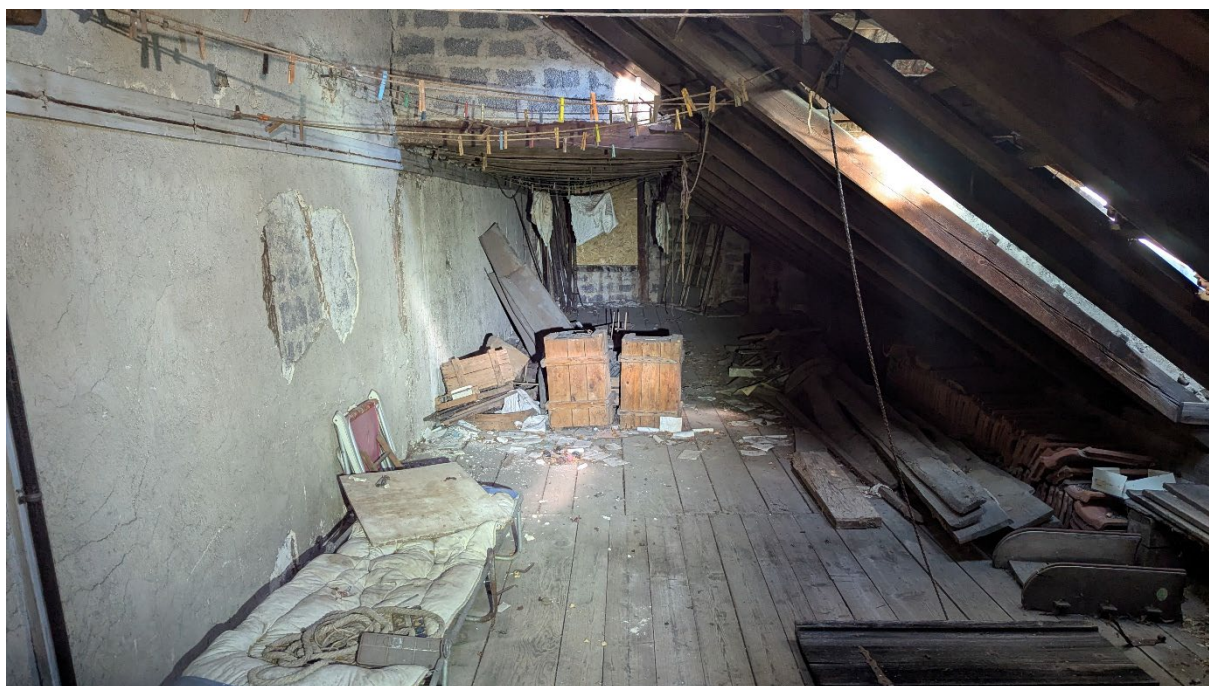
Abbildung 3: Dachboden mit ausgeprägtem Lichteinfall.
