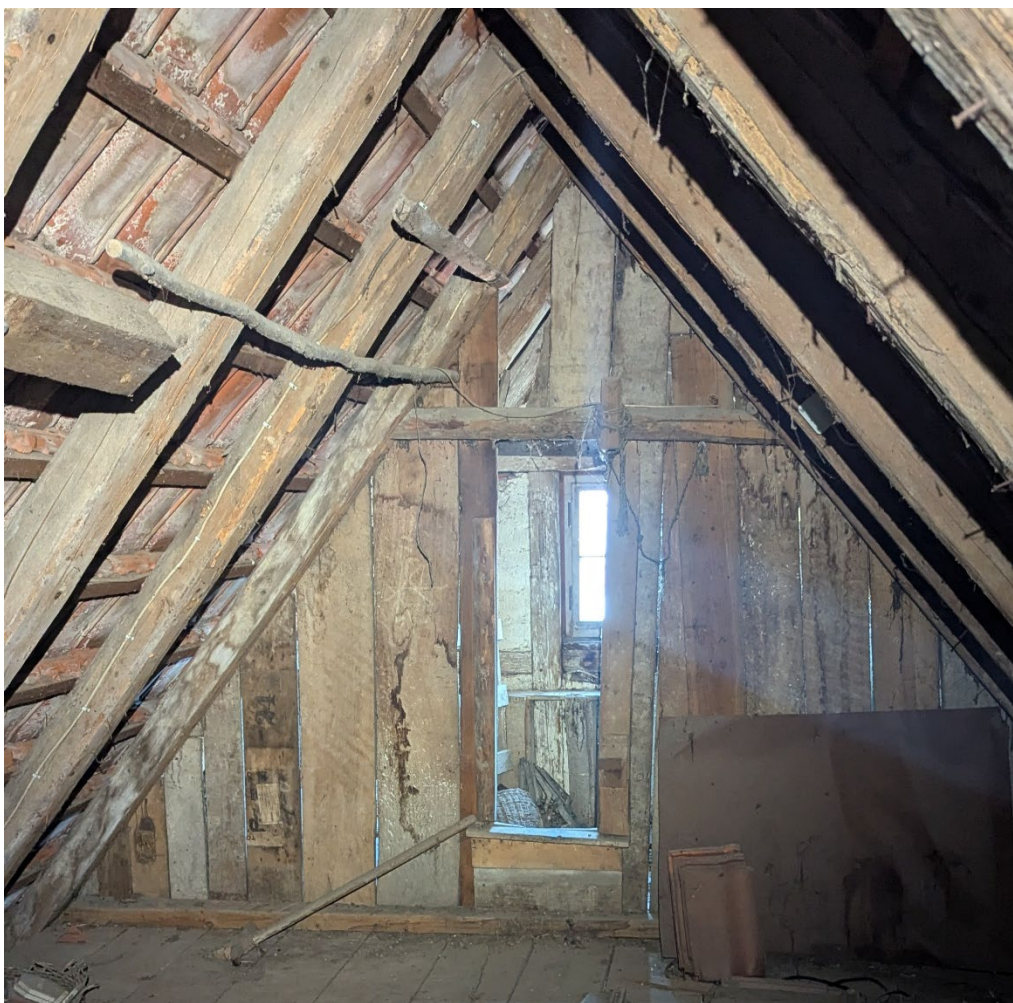
Abbildung 10: Dachstuhl der Scheune.
