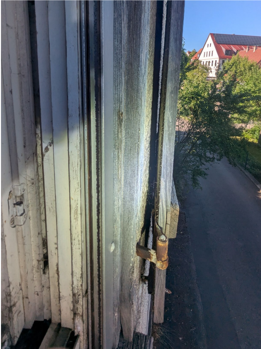
Abbildung 8: Keine Nachweise von Fledermäusen hinter den Fensterläden.
